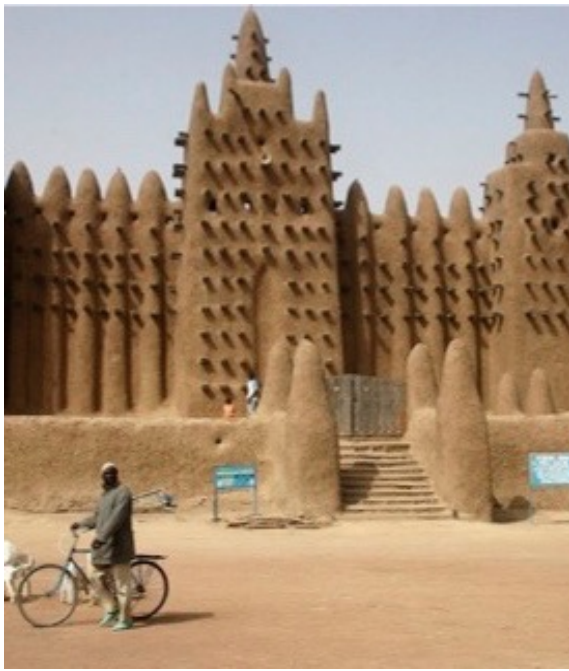
Mosquée de Djenné (XXe siècle), Mali
