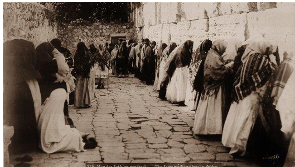
L'accès au mur, vers 1880 (photo Félix Bonfils)
